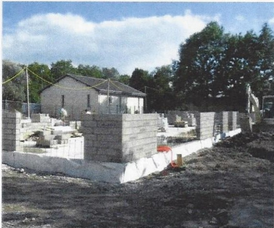
Le bâtiment en cours de construction. (Photo MJC)
